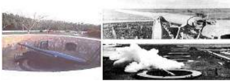
ภาพที่ 1.1-2 ป้อมแปลงไฟฟ้า
