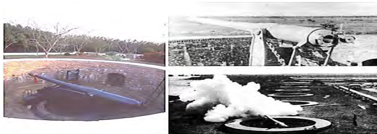
ภาพที่ 1.1-2 ป้อมแผลงไฟฟ้า
